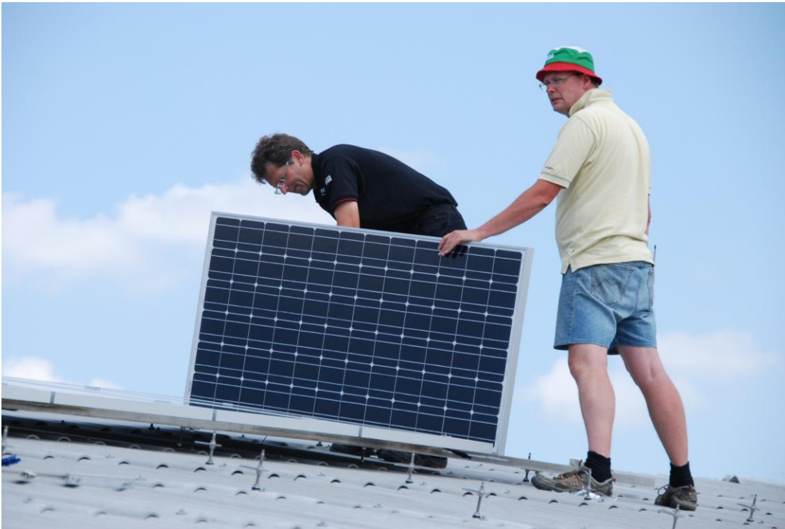
Onsdag den 27. juli var montagearbejdet i fuldt sving hos Lars Thorlund (t.h.), som selv deltog i arbejdet. El-installatør Kaj Nygaard ses til venstre i billedet.
